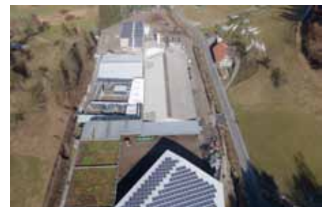
Vergärungsanlage und Kompostierwerk
